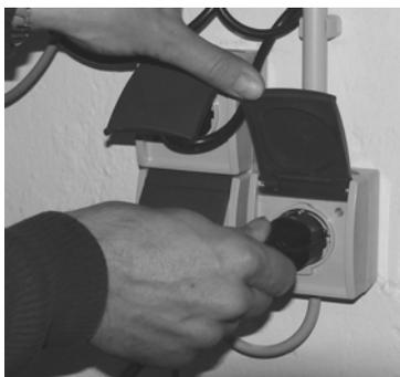
5. Introducir cable de distribución del motor de la bomba en el enchufe.
