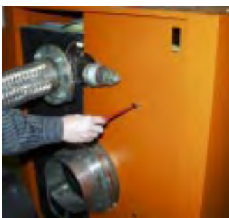
Racor de las chapas de revestimiento traseras al elemento de fundición trasero
