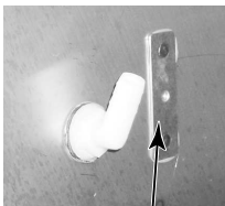
PUERTO COMÚN DE DOSIFICACIÓN DE DETERGENTE QUE DEBE COMPRAR EL CLIENTE
