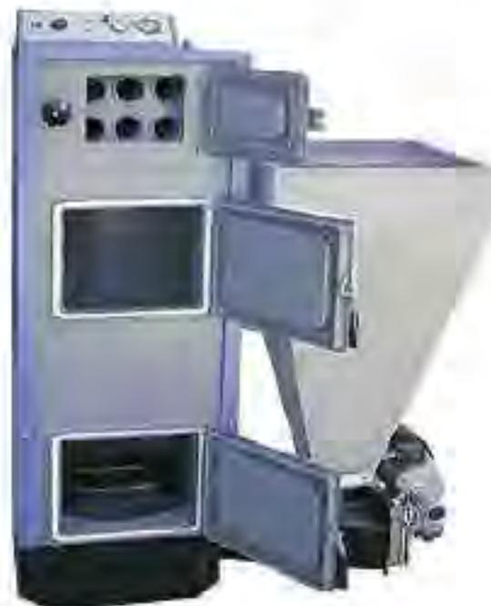
El combustible debe mantener un nivel dentro del quemador de hierro fundido, sin llegar a rebosar y obstruir los orificios de salida del aire. Para ello, es conveniente regular al mínimo la alimentación de combustible, para ir la aumentando poco a poco hasta conseguir mantener un nivel más o menos constante, y una llama viva y azulada.
