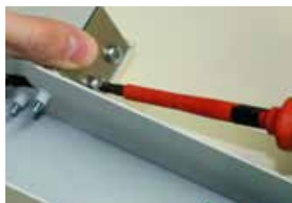
7. Ajuste la tapa trasera del soporte de la sonda
