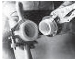
Si la fundición no está completa, corte el extremo de tubo fundido. Use un nuevo accesorio y repita el proceso de preparación y calentamiento de nuevo.
