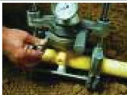
Raspe la superficie de fusión de la tubería principal con una lija de 50 a 60 granos para retirar la capa de oxidación y contaminantes. El área raspada debe ser mayor que el área cubierta por la base del accesorio. Después de la abrasión, retire los residuos con un trapo limpio y seco.
