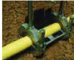
Pula la superficie de fusión del accesorio con una lija de 40 a 60 granos para retirar la capa de oxidación y contaminantes. Después de la abrasión, retire los residuos con un trapo limpio y seco.
