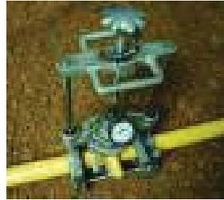
Instale la herramienta de fusión de asiento sobre la tubería principal según las instrucciones del fabricante. La herramienta debe quedar centrada sobre una ubicación limpia y seca donde el accesorio se va a fusionar. Asegure la herramienta a la tubería principal. Se recomienda el uso de un cojinete o soporte bajo la tubería en tamaños de tubería principal de 6" IPS y más pequeños.
