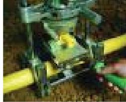
Aplique la fuerza térmica inicial hasta que se observe primero la fusión sobre la corona de la tubería principal, (El calor inicial es el término usado para describir el paso de calentamiento inicial (desarrollo del cordón) para desarrollar un cordón de fusión sobre la tubería principal y normalmente esto ocurre en 3 a 5 segundos) y luego reduzca la fuerza hasta la fuerza térmica mínima (fuerza de desarrollo del cordón) (vea la etiqueta del accesorio o use 0 psi).
