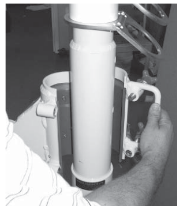
Figura 11 - Installazione del montante di ancoraggio
