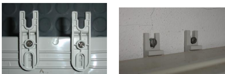
Fijaciones del Cuadro eléctrico de Hidrion SAL a la pared.
