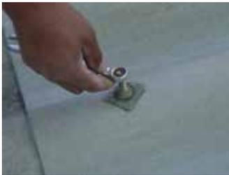
Aflove y retire las fijaciones de la lámina dañada, en la lámina que monta solamente afloje las fijaciones.
