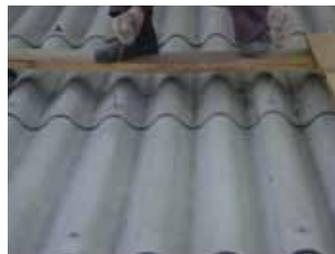
Introduzca dos alambre en los orificios de la lámina superior para levantarla un poco y permitir que la nueva lámina pueda deslizarse (observe que el tablón de apoyo no aprisiona la lámina superior, puede utilizar dos polines de madera para que el tablón de apoyo quede libre).
