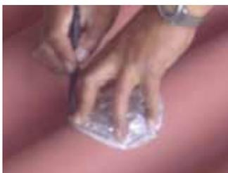
Haga el trazado del contorno de la abertura deseada, siempre sobre la parte alta de la onda.
