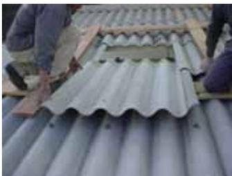
Para colocar la nueva lámina, levante la punta de la lámina que monta, y con un movimiento suave de vaivén, empuje la nueva lámina.
