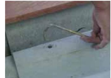
Introduzca el gancho con el doblez, en el orificio de la lámina (el orificio puede agrandarse a  $\frac{1}{2}$ "  $\varnothing$  para permitir introducir el gancho).
