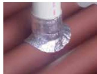
Coloque la pieza que va a utilizar (tubería, poste, etc). Para evitar filtraciones, coloque un cuello metálico debidamente asegurado a la pieza que va a colocar. En los sitios de unión del cuello metálico con la lámina y el tubo impermeabilice con un sellador adecuado.
