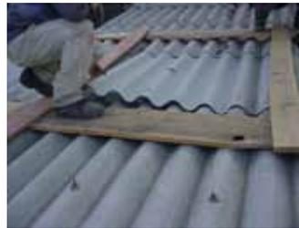
Con un movimiento suave de vaivén, retire la lámina dañada.
