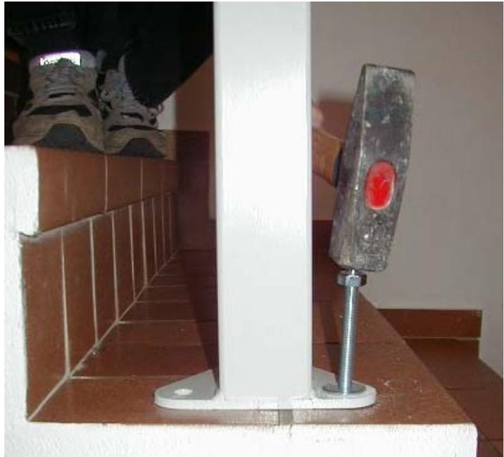
**Nota:** Los pernos usados para montaje en cemento són mas largos que los usados en madera. No uses tacos en los trabajos con madera.
