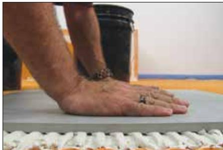
2 Colocar firmemente la baldosa sobre el material de instalación, asegurándose de observar el tiempo abierto de la capa de mortero. Si se forma una película en la superficie del mortero antes de la instalación de la baldosa, retirarlo y volver a aplicarlo.
