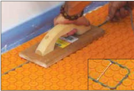
**4** Introducir los cables de calefacción entre los nódulos, con un espaciado mínimo de 3 nódulos (3-1/2 pulgadas – 9 cm). Un espaciado menor puede traer como consecuencia un sobrecalentamiento que dañaría las estructuras de la edificación.
