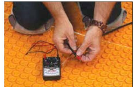
**7** Una vez terminada la instalación del cable de calefacción y del sensor de temperatura del piso, realizar las pruebas nuevamente y anotar los resultados en el registro de pruebas al cable de calefacción (página 26).
