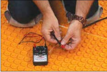
**1** Antes de retirar el cable de calefacción de la bobina, se debe llevar a cabo el primer grupo de pruebas requeridas y se deben anotar los valores en el registro de pruebas al cable de calefacción (página 26). Si se detecta alguna defacto o daño durante las pruebas, devolver el cable de calefacción al establecimiento donde lo compró.
