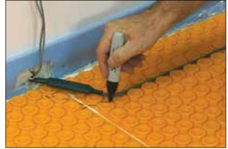
**3** Marcar dónde se va a ubicar el empalme frío/caliente, cortar la membrana DITRA-HEAT, e insertar el empalme. Quizás sea necesario asegurar momentáneamente el empalme al piso con mortero adhesivo o adhesivo (p.ej. KERDI-FIX o pegamento en caliente).
