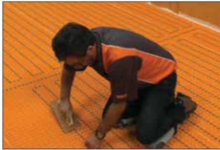
**5** Se debe tener cuidado de no dañar los cables durante la instalación, especialmente antes de adherir los cables a la membrana.
