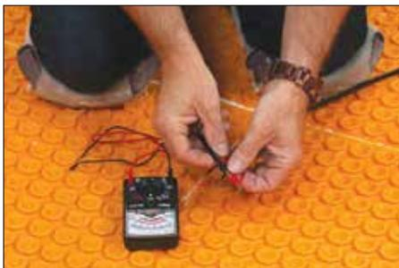
4 Una vez terminada la instalación de las baldosas, comprobar otra vez el cable de calefacción y anotar los resultados en el registro de pruebas al cable de calefacción (página 26).
