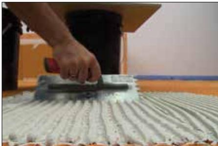
1 La baldosa se puede instalar inmediatamente sobre la membrana DITRA-HEAT; no es necesario esperar a que el mortero fragüe. Rellenar la membrana con mortero adhesivo no modificado y aplicar más mortero sobre la membrana con una llana que sea apropiada para el tamaño de la baldosa.
