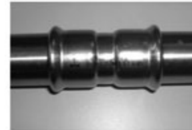
Gire ligeramente el tubo, insertándolo en la pieza de unión hasta el tope. Rotate the tube slowly as you insert it in the joint until the limit.
