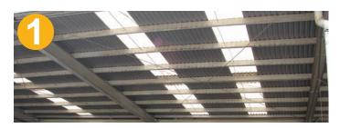
En este caso se utilizan ángulos de acero para la facilidad y rapidez de instalacióny así poder soportar el peso del MBI sin ningún problema.
