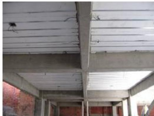
Los paneles pueden ser utilizados para la conformación de losas en conjunto con estructura metálica. Esta opción representa un ahorro para el cliente ya que este sistema puede alcanzar claros mucho mayores sin la necesidad de colocar vigas secundarias de apoyo para la losa como normalmente se colocan en el sistema que habitualmente se usa para la conformación de losas en conjunto con estructura metálica.
