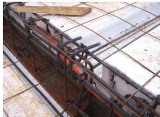
Los paneles no solo se pueden colocar integrándolos a una viga, también se pueden colocar sobre estos si así lo demanda la estructura del edificio. Esto se especifica en el siguiente diagrama.
