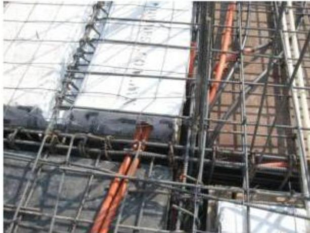
La colocación de instalaciones es muy sencilla, ya que el sistema cuenta con cavidades que permiten la disposición de las mismas evitando la necesidad de ranuras posteriores al hormigonado. De igual forma, las canaletas internas del panel, están provistas de perforaciones que permiten el paso en cualquier sitio de las canalizaciones, evitando así la necesidad de colocar las instalaciones con antelación, y permitiendo la colocación de las mismas posteriores al hormigonado.
