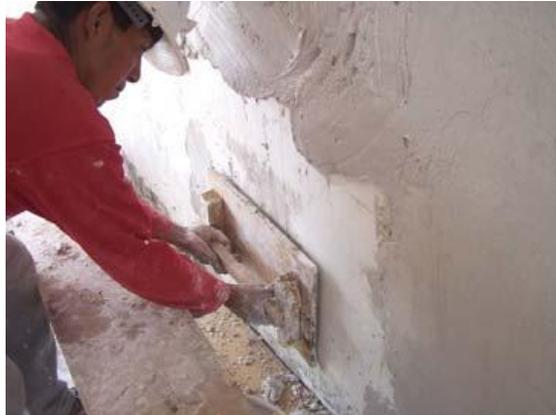
El mortero Cemento-Arena no tiene una buena adherencia a largo plazo sobre el poliestireno por lo que hay que agregar elementos que permitan una fijación duradera del recubrimiento. Con este tipo de recubrimientos se pueden presentar fisuras o agrietamientos estructurales.
