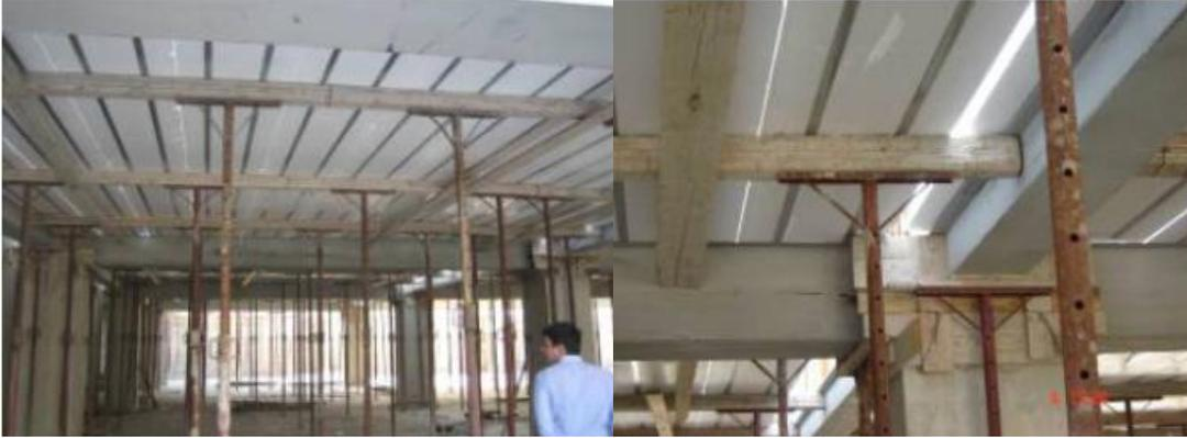
Una vez que está colocado el alzaprimado, se puede comenzar a trabajar en la colocación del acero de refuerzo de las nervaduras especificado en el proyecto estructural. El acero que se coloque como refuerzo deberá de estar calzado para que al momento de ser hormigonada la losa obtenga el recubrimiento de concreto necesario.
