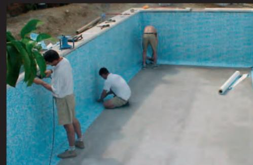
del revestimiento recubra la parte añadida para que la soldadura no sea visible desde la superficie.
