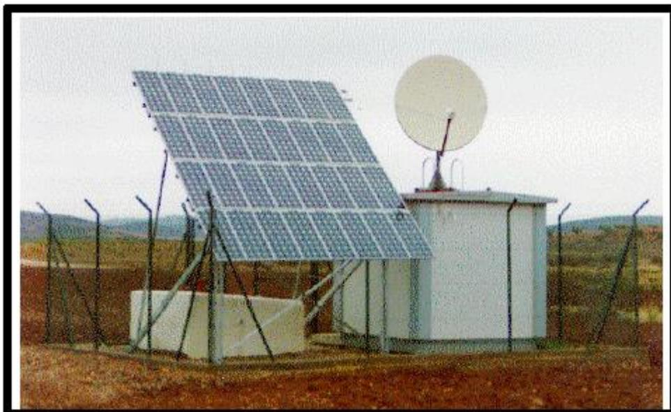
Están compuestas de células capaces de convertir la luz en electricidad. Todas las células del módulo están unidas entre sí, para poder sumar su potencia y alcanzar conjuntamente la potencia nominal del módulo.
