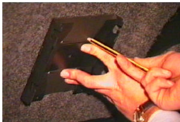
FIG 6: Utilización de la base soporte amplificador para marcar taladros fijación.
