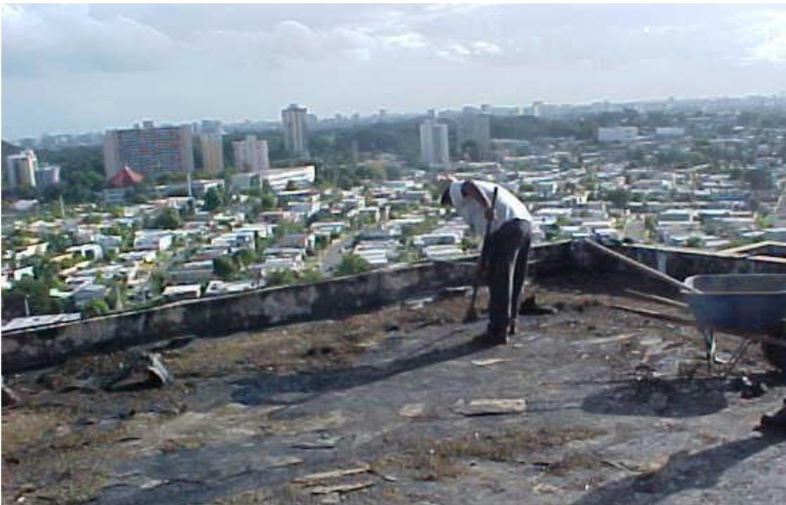
En caso de sistemas existentes en buenas condiciones puede omitirse la remoción siempre y cuando estén en buenas condiciones. En este caso repare el sistema existente hasta que elimine las filtraciones al interior del edificio por completo antes de la aplicación del **EcoPasta PA-850**. Realice sobre el sistema existente los trabajos de preparación de superficie que apliquen.
