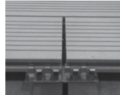
**ES.** Coloque el borde de la fijación sobre el lateral del rastrel, así el tornillo quedará centrado con respecto a éste.
