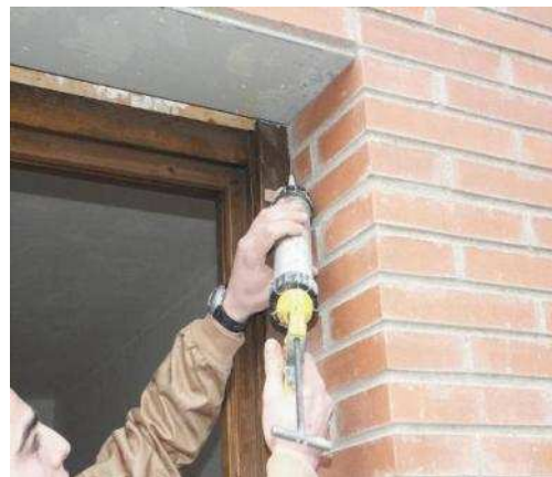
Ilustración 10. Detalle de aplicación de sellante exterior.
