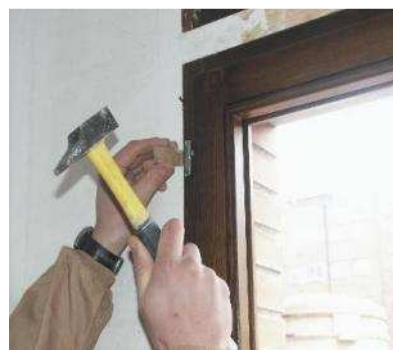
Ilustración 5. Calzado de la ventana para su posterior fijación
