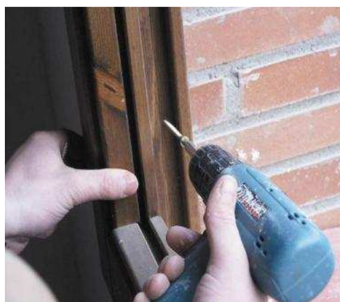
Ilustración 7. Detalle de fijación con tornillo 5x70
