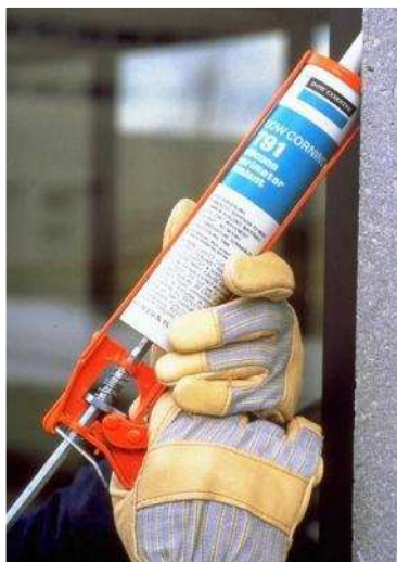
Ilustración 15. Detalle de aplicación de sellante mediante pistola.
