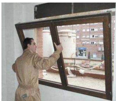
Ilustración 4. Alojamiento de la ventana en el premarco.
