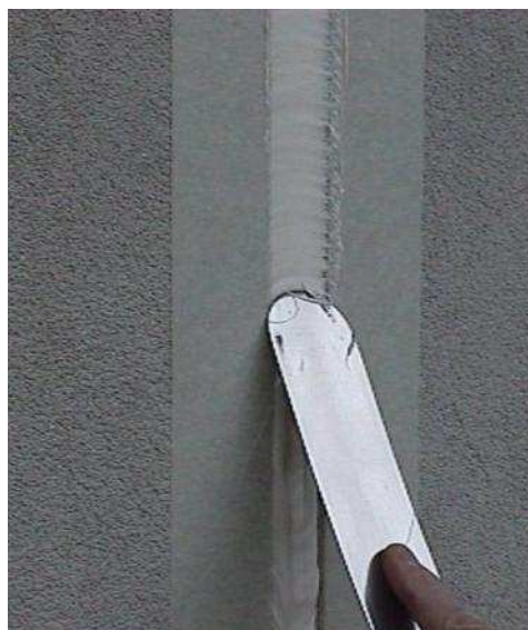
Ilustración 16. Repaso y alisado del cordón de sellado.
