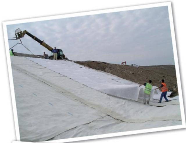
Se desenrolla el primer rollo de **InterDRAIN** en el sentido de la máxima pendiente (de arriba hacia abajo), asegurándose que queda en contacto con el terreno. Posteriormente se desenrollará el segundo rollo al lado del primero.
