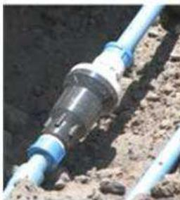
Es recomendable instalar un regulador en el cabezal de riego para compensar las posibles fluctuaciones de presión que se puedan producir en la red de entrada.
