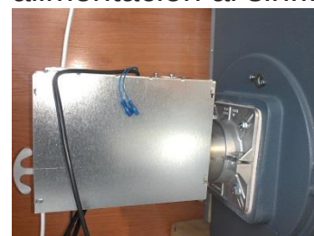
Sujeción del quemador a la caldera
