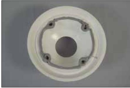
**2** Aplicar un cordón uniforme de 6 mm a 10 mm (1/4" a 3/8") de KERDI-FIX a la brida del desagüe instalado. Alinear los agujeros del anillo adaptador con los agujeros de los tornillos en el desagüe instalado y colocar el anillo adaptador sobre la brida del desagüe instalado. Colocar los tornillos. Después de enroscar los tornillos, apriételos un 1/4 de vuelta más. No apretarlos demasiado porque esto podría dañar el adaptador y provocar fugas.
