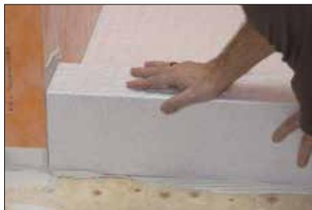
2 Presionar el reborde o rampa firmemente en su lugar. Mirar debajo de el reborde o rampa para asegurarse de que el recubrimiento esté completo.
