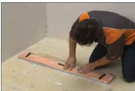
**4** Colocar firmemente el soporte de la canal y el desagüe KERDI-LINE en el mortero sobre el suelo y conectar la sección cortada de la tubería al sifón. Revisar para asegurarse de que el drenaje KERDI-LINE está a nivel.
