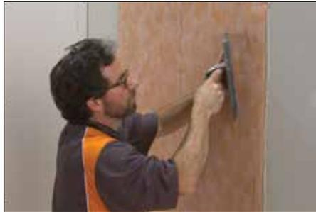
**2** Aplicar el mortero adhesivo no modificado con una llana dentada en "V" de 1/4 x 3/16 de pulgada (6 mm x 5 mm) o la llana KERDI-TROWEL. Presionar la membrana KERDI o KERDI-DS en el mortero en toda la superficie para asegurar una unión completa y eliminar bolsa de aire.
