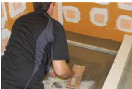
2 Rellenar el resto de la base de la ducha con mortero y crear una pendiente de 1/4 de pulgada (6 mm) por cada 12 pulgadas (305 mm) utilizando el platillo de conexión y un recocado perimetral como guías.
