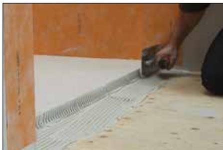
1 Aplicar una capa de mortero adhesivo no modificado en el piso y sobre el borde del panel de ducha, utilizando una llana con dientes cuadrados o en "U" de 1/4 x 3/8 de pulgada (6 mm x 10 mm).
