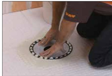
3 Rellenar completamente el rebaje en el panel de ducha con mortero adhesivo. Presionar firmemente el desagüe KERDI-DRAIN en la capa de mortero para asegurar un soporte total para el platillo de conexión.
