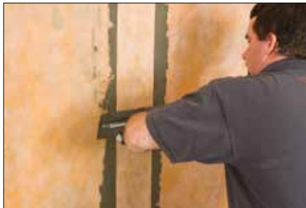
**5** Las uniones deben hacer sobreponiendo 50 mm (2") los bordes de la membrana KERDI o aplicando KERDI-BAND con mortero adhesivo no modificado sobre la unión de dos membranas.
