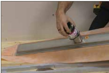
**1** Primeramente ensamblar los componentes en seco. Medir y cortar una sección de tubería para conectar el acople al sifón debajo del suelo, usando el soporte de la canal como espaciador.
