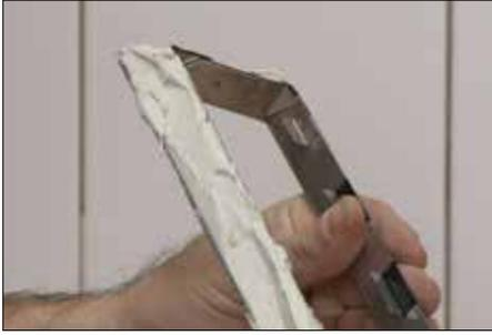
**1** Aplicar mortero adhesivo no modificado en la parte inferior del marco de la rejilla e insertarlo en la canal, asegurándose de que exista un apoyo y cobertura totales del marco. Insertar los separadores de espuma en el marco de la rejilla para reforzarlo durante el resto de la instalación.
