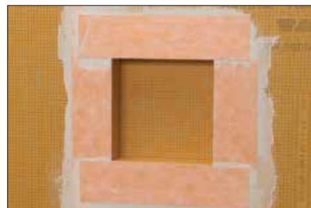
**3** Sellar las uniones entre el nicho y las paredes usando KERDI-BAND con mortero adhesivo no modificado asegurando un empalme de 2 pulgadas (50 mm) en todas las direcciones.
