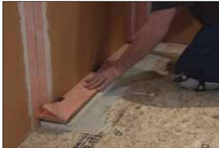
**2** Aplicar mortero adhesivo no modificado a la parte superior del soporte de la canal y presionar firmemente la canal en el mortero, asegurando un apoyo total del platillo de conexión. Revisar para comprobar que el drenaje KERDI-LINE esté a nivel.
