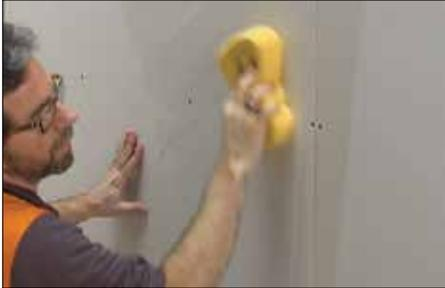
**1** Limpiar el polvo u otros residuos que queden sobre la superficie del soporte mural sólido. Humedecer las superficies secas y porosas para evitar el secado prematuro o la formación de una película en la superficie del mortero adhesivo.
