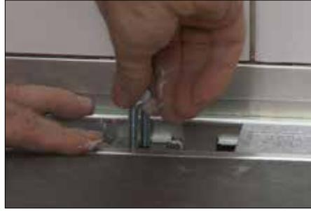
**2** Insertar los separadores plásticos de regulación de la altura con tornillos incorporados debajo de las pestañas a lo largo de la parte interior del marco para regular la altura, de forma tal que la superficie del marco esté a ras con las baldosas. Los separadores se pueden regular simplemente girando los tornillos con los dedos.
