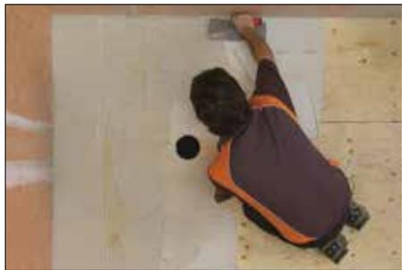
1 Aplicar mortero adhesivo no modificado sobre el sustrato, utilizando una llana de 6 mm x 10 mm (1/4" X 3/8") con dientes cuadrados o en forma de U.
