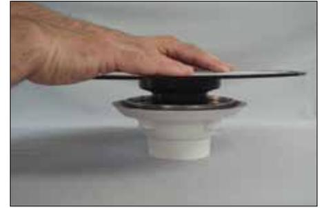
**3** Insertar el platillo de conexión dentro del anillo adaptador. Asegurarse de que el platillo esté bien apoyado sobre mortero o sobre la sección central del panel de ducha de poliestireno. Dependiendo de la altura del desagüe instalado, puede ser necesario instalar un panel de poliestireno, paneles de cemento, etc. antes de instalar el panel de ducha. Instalar dicho panel según las instrucciones que aparecen en la página 22.
