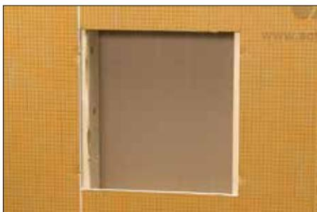
**1** Determinar la ubicación deseada para el nicho de ducha y trazar el contorno de la parte exterior del reborde del KERDI-BOARD-SN, asegurándose que las líneas están niveladas y a plomo. Cortar y retirar el KERDI-BOARD de manera que el nicho quede sujeto en ambos lados por las vigas o soportes de pared.
