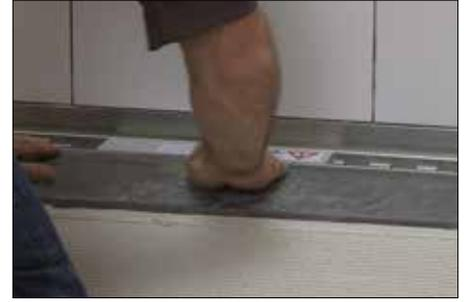
**3** Instalar las baldosas en la base de ducha con mortero adhesivo no modificado, asegurando una cobertura total. Hacer los ajustes finales para asegurar que el marco de la rejilla esté a ras con las baldosas que lo rodean.
