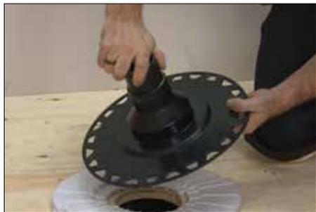
1 Primeramente ensamblar los componentes en seco. Medir y cortar una sección de tubería para conectar el desagüe KERDI-DRAIN al sifón, usando como separador la sección central desmontable del panel o los separadores de espuma incluidos con el kit de desagüe. Preparar y conectar el sifón, la tubería y el desagüe KERDI-DRAIN con limpiador, tapaporos y cemento PVC o ABS según las instrucciones del fabricante del cemento solvente.
