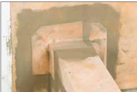
**7** Sellar la unión entre el reborde de la ducha y la pared utilizando los ángulos internos y externos KERDI-KERECK-F y mortero adhesivo no modificado.
