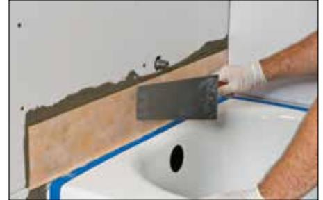
**3** Aplicar la banda impermeable KERDI-BAND o secciones de membrana KERDI cortadas de un ancho de 125 mm (5"). Aplicar firmemente la membrana en el mortero adhesivo y en el KERDI-FIX para asegurarse de que el recubrimiento esté completo, y eliminar todas las burbujas de aire.
