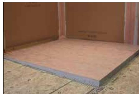
**Nota:** Cuando el desagüe KERDI-LINE esté colocado en un lugar intermedio (p.ej. el centro de la ducha) se recomienda cortar el panel KERDI-SHOWER-L de manera uniforme en los extremos para lograr una altura consistente en la primera fila de baldosas. Cuando el drenaje KERDI-LINE se ubica adyacente a la pared, cortar el panel KERDI-SHOWER-LS por el borde más grueso para garantizar una transición a ras con el desagüe.
