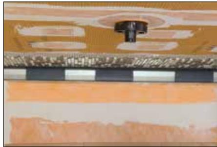
**2** Insertar los separadores en la canal. Instalar las baldosas adyacentes en las paredes contiguas y en la base de ducha hasta la altura de los separadores utilizando mortero adhesivo no modificado, asegurando una cobertura total. Eliminar el material de instalación sobrante.
