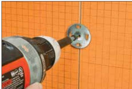
**2** Alinear los paneles sobre el centro de los postes de madera o de metal. Los tornillos se pueden ubicar entre paneles adyacentes de forma tal que las arandelas unan los bordes de ambos paneles. La distancia máxima permitida entre los tornillos desde los centros es de 12 pulgadas (30 cm) en las paredes y de 6 pulgadas (150 mm) en los techos.
