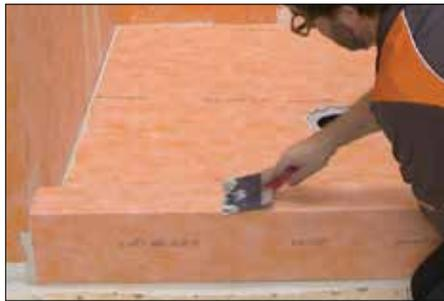
**5** Repetir el proceso para instalar la membrana sobre el reborde o la rampa. Las uniones en la membrana se construyen con solapes de 2 pulgadas (50 mm) entre los bordes o alineando los bordes de la membrana e instalando KERDI-BAND justo sobre la unión entre estas. Instalar los ángulos prefabricados KERDI-KERECK en todos los ángulos interiores y exteriores.
