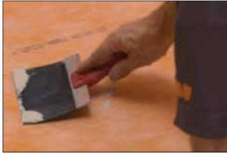
**2** Colocar la membrana KERDI o KERDI-DS sobre la capa de unión y presionar la membrana en toda la superficie para asegurar una cobertura completa y eliminar bolsas de aire. La membrana debe llegar hasta el platillo de conexión de acero inoxidable y hasta los bordes de la base de ducha.
