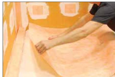
3 Tan pronto como se pueda caminar sobre la base de mortero, comenzar la impermeabilización con la membrana KERDI.
