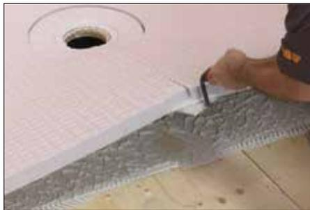
2 Asegurarse de que el panel KERDI-SHOWER-ST esté firmemente anclada en el mortero adhesivo. Mirar debajo de el panel para asegurarse de que el recubrimiento esté completo.
