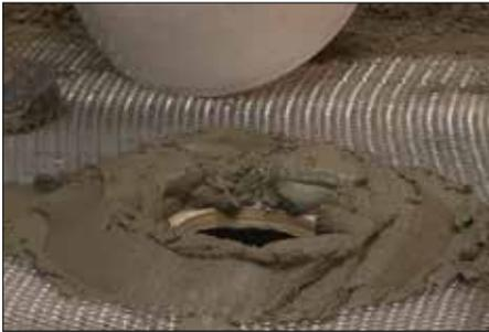
**1** Colocar una corona de mortero alrededor del agujero en el suelo y presionar firmemente el sumidero en el mortero. El encofrado del sumidero y el platillo de conexión deben estar totalmente apoyados para prevenir los daños en la instalación de las baldosas (ej.: la lechada puede resquebrajarse alrededor del sumidero). Cuando KERDI-DRAIN es instalado sobre una base de madera, el espesor mínimo necesario para el mortero en el perímetro del platillo de conexión es de 25 mm (1").
