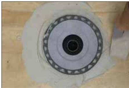
2 Aplicar mortero adhesivo sobre el sustrato y sobre las partes superior e inferior de la sección central desmontable del panel KERDI-SHOWER-ST. Deslizar la sección central hasta su lugar por debajo del desagüe para asegurar un soporte sólido y uniforme para el platillo de conexión.
