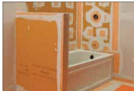
**7** Sellar las conexiones a las medias paredes con los ángulos prefabricados KERDI-KERECK y mortero adhesivo no modificado.
