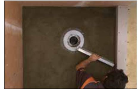
**2** La capa de mortero se coloca a nivel con la parte superior del platillo de conexión del desagüe KERDI-DRAIN. Hacer una pendiente en la base de mortero de 1/4 de pulgada (6 mm) por cada 12 pulgadas (305 mm) utilizando el platillo de conexión y un recrido perimetral como guías.
