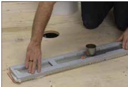
**2** Aplicar mortero adhesivo no modificado a la parte superior del soporte de la canal con una llana dentada y presionar firmemente el soporte contra la parte inferior de la canal. Unir el acople mecánico a la salida del desagüe y a la sección cortada de tubería según las instrucciones del fabricante del acople.
