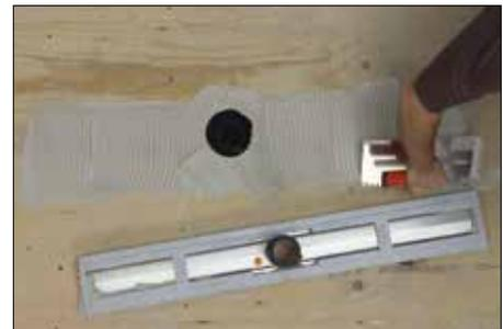
**3** Aplicar mortero adhesivo no modificado con una llana en el lugar donde se va a ubicar el desagüe. Preparar el sifón y la sección de tubería cortada con limpiador, tapaporos y cemento PVC o ABS según las instrucciones del fabricante del cemento solvente.
