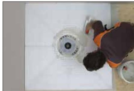
3 Aplicar mortero adhesivo no modificado sobre el sustrato con una llana de dientes cuadrados o en forma de 'U' de 1/4 x 3/8 de pulgada (6 mm x 10 mm). Colocar el panel KERDI-SHOWER-ST y adherir firmemente en el mortero. Revisar la parte inferior del panel para asegurar que se haya logrado un contacto y soporte total.
