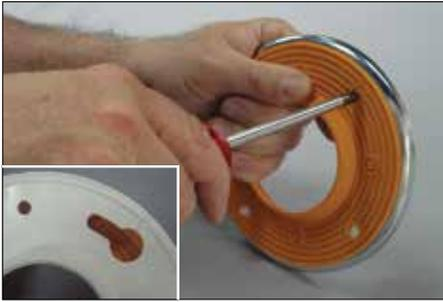
**1** Retirar la junta de unión del desagüe instalado. Guardar los tornillos para instalar el anillo del adaptador. Alinear los agujeros de la junta de unión con los agujeros correspondientes en el anillo del adaptador. Recortar los agujeros a través del anillo de acero inoxidable del adaptador.
