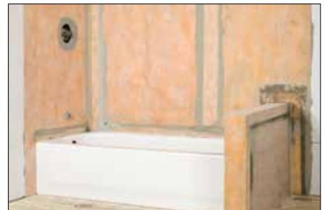
**8** Una vez que la membrana, incluyendo las uniones, los ángulos y las medias paredes estén completamente adheridas y por tanto impermeabilizadas, el ensamblado está listo para el recubrimiento con baldosas.
