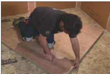
1 Nivelar el suelo antes de la instalación del panel de ducha. De ser necesario, cortar el panel a la medida antes de su aplicación. El tamaño del panel puede ser ampliado usando mortero, el cual debe ser recubierto con la membrana KERDI.
