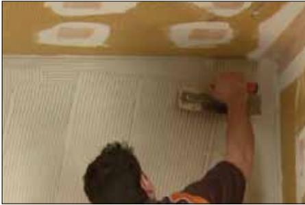
**1** Aplicar mortero adhesivo no modificado a la base de la ducha con una llana dentada en "V" de 1/4 x 3/16 de pulgada (6 mm x 5 mm) o la llana KERDI-TROWEL. El cemento debe ser mezclado a una consistencia bastante líquida, pero capaz de seguir manteniendo las dentadas hechas por la llana.
