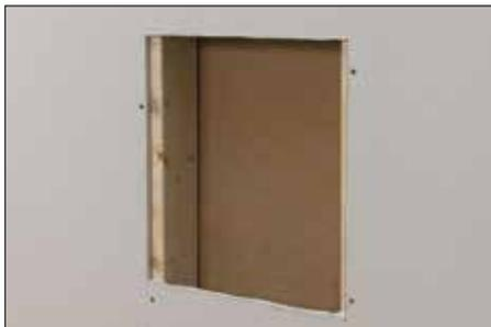
**1** Determinar la ubicación deseada para el nicho de ducha y trazar el contorno de la parte exterior del reborde del KERDI-BOARD-SN, asegurándose que las líneas están niveladas y a plomo. Cortar y retirar el panel de yeso de manera que el nicho quede sujeto en ambos lados por las vigas o soportes de pared.
