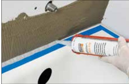
**2** Colocar una cinta adhesiva para proteger la bañera. Aplicar mortero adhesivo no modificado sobre el panel de soporte mural con una llana dentada en V de 6 mm x 10 mm (1/4" X 3/8") o la llana KERDI-TROWEL. Sellando la separación de 1/4" (6 mm) de ancho entre el panel de soporte mural y la bañera con un cordón con el sellador KERDI-FIX o un sellador equivalente.
