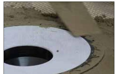
**2** Compactar el mortero restante debajo del desagüe hasta el agujero de drenaje para asegurar un soporte sólido y uniforme bajo el platillo de conexión. A continuación colocar la base de mortero de acuerdo a las instrucciones expuestas anteriormente.
