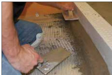
1 Colocar un recocado de mortero en la posición opuesta de la canal KERDI-LINE instalada.
