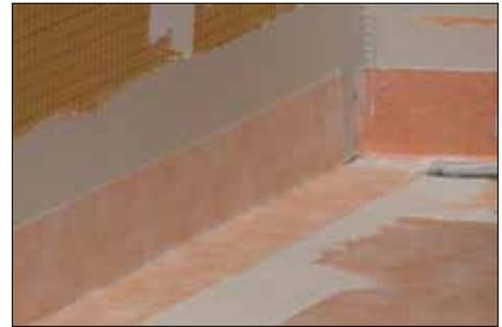
**3** Las uniones en la membrana se construyen con solapes de 2 pulgadas (50 mm) entre los bordes o alineando los bordes de la membrana e instalando KERDI-BAND, justo sobre la unión entre estas, usando mortero adhesivo.
