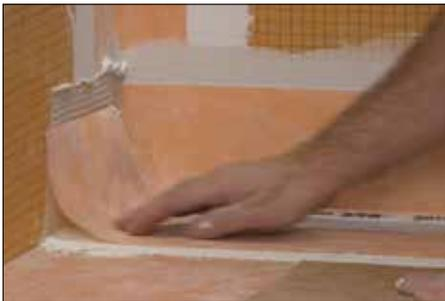
**4** La membrana KERDI integrada en el desagüe KERDI-LINE se incorpora a la impermeabilización contigua utilizando mortero adhesivo no modificado. El manguito KERDI se debe cortar y doblar donde el desagüe KERDI-LINE se instala adyacente a las paredes.
