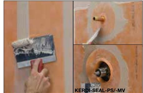
**3** Las uniones en la membrana se construyen con solapes de 2 pulgadas (50 mm) entre los bordes o alineando los bordes de la membrana e instalando KERDI-BAND justo sobre la unión entre estas. Cualquier perforación a través de la membrana (p.ej. la válvula mezcladora, el cabezal de ducha, etc.) se debe sellar con KERDI-SEAL-PS/-MV, KERDI-FIX, o cualquier otro sellador apropiado.
