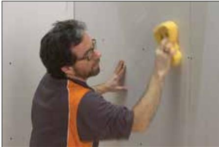
**1** Limpiar el polvo u otros desechos que queden sobre la superficie del soporte mural sólido. Humedecer las superficies secas y porosas para evitar el secado prematuro o la formación de una película en la superficie del mortero adhesivo.
