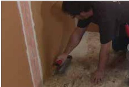
**1** Aplicar mortero adhesivo no modificado sobre el substrato donde se va a instalar el desagüe con una llana dentada y adherir firmemente el soporte de la canal en el mortero.
