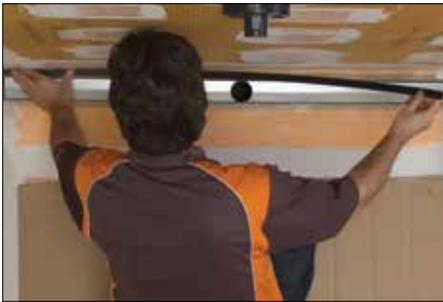
**1** Retirar la lámina protectora de la tira de recubrimiento y adherir al platillo de conexión en las zonas de paredes adyacentes. Colocar la tira a lo largo del borde de la canal. La tira de recubrimiento esconde y protege la superficie de la membrana KERDI debajo de la baldosa instalada en el paso 3. Cuando se instalan baldosas en la base de ducha alrededor de los extremos de la canal, no es necesario utilizar la tira de recubrimiento en estos lugares.
