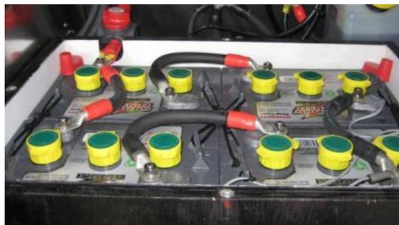
Instalaciones pequeñas de un solo panel normalmente necesitan una sola batería. Sin embargo, para instalaciones entre 100-235W es posible que se tendrá que conectar dos baterías para obtener el voltaje y capacidad (Ah) deseado. A veces una sola batería al voltaje y capacidad necesarios saldrá más cara que incluir dos baterías menos potentes. El voltaje de un grupo de baterías = (numero de baterías conectados en serie) x voltaje una batería. La capacidad de un
