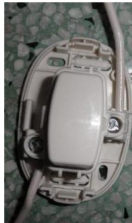
Aunque necesitan más cable, es preferible utilizar los interruptores que se montan a la pared, porque engrapar los cables mejora la resistencia mecánica. Se trata de evitar el riesgo de que halen el cable suelto algún día, con posibles daños a la instalación. Hay que consultar a los dueños de la casa sobre la posición de estos interruptores.
