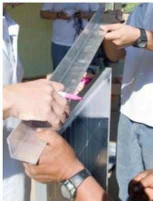
2. Los tornillos deben estar posicionados para que las cabezas, al interior del marco, no rasquen la parte de abajo del panel. Un rayón podría arruinar el panel. Asegúrese también que el angular esta nivelado con el marco del Panel, para que quede nivelado con la superficie del techo.
