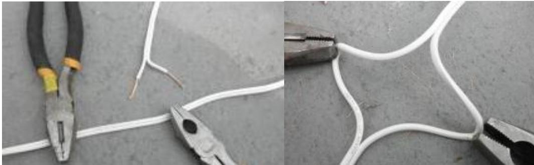
Cortar el aislante del alambre a todo su alrededor (sin dañar el alambre de cobre.)
