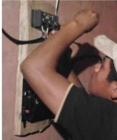
La mejor fijación en pared de block sería con tarugos y tornillos:
