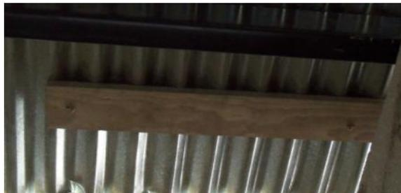
5. Después se puede atornillar el angular superior a esta tabla (véase paso 3.) Es más fácil de conseguir buena fijación si la persona al interior continúa empujando para arriba. Si los tornillos de techo no son lo suficientemente largos, utilice clavos de 4".
