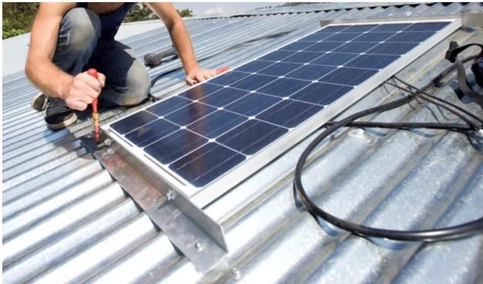
Cortar los dos angulares a la anchura del panel + 20 cm, dejando 10cm a cada lado del Panel.
