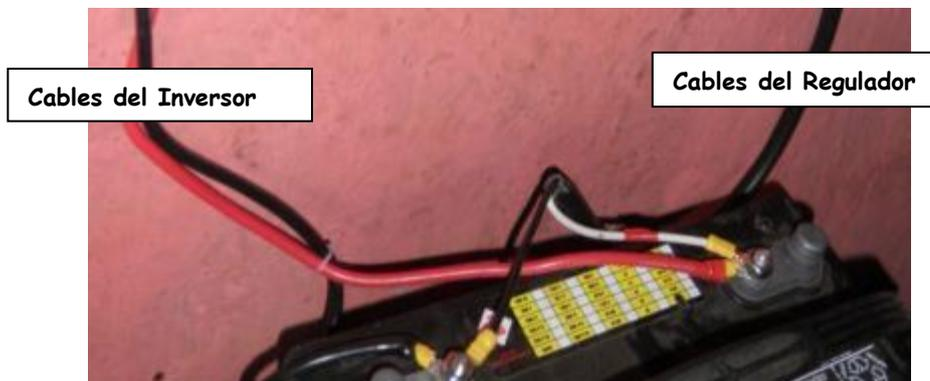
Aprieta completamente las tuercas de las terminales de la batería con una llave fija para asegurar buenas conexiones.
