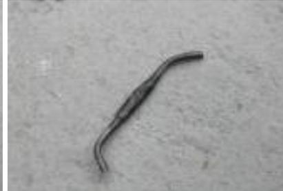
Prensar el lado del otro cable. Proteger el empalme con cinta aislante
