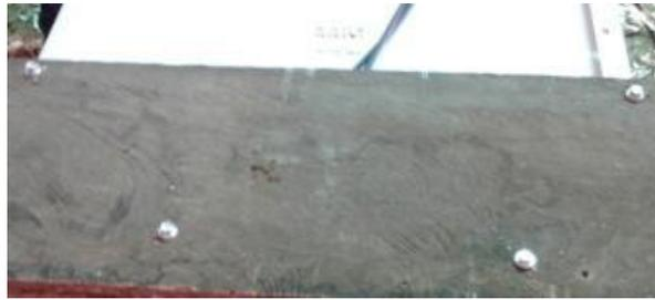
Se sienta el Panel en su posición según la inclinación querida. Luego se puede atornillar la tabla de soporte a la primera tabla. Utiliza tornillos suficientes largos para que suficiente rosca entre la primera tabla y asegura que haya buen contacto entre las dos superficies de madera.
