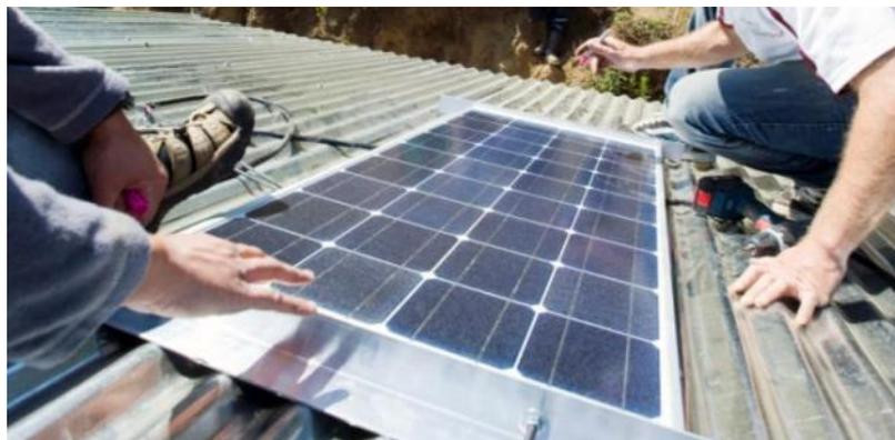
3. Ya se puede anclar el angular a la viga con tornillos de lamina de 3½". Utilice el barrenador inalámbrico con una broca de copa de 3/8". Si el tornillo patina sobre la lámina en vez de
