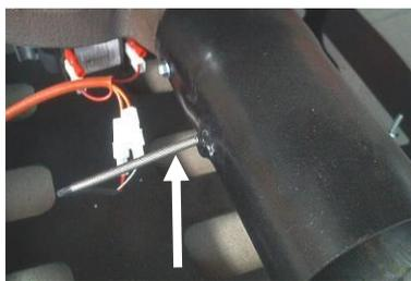
En caso de número extraños de la temperatura de los humos, sustituir los dispositivos electrónicos (véase sustitución de los dispositivos electrónicos) y, si necesario, la sonda de temperatura de los humos.
