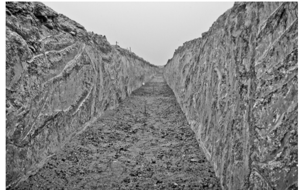
Plantillas antes de colocar tubería
