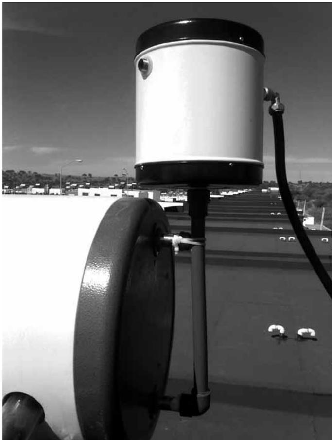
1. Coloque cinta teflón en la entrada de agua fría del termotanque (conexión lateral identificada con color azul).
