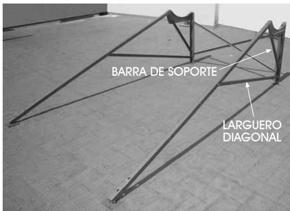
Ensamblar al marco de la estructura las barras de soporte y las barras diagonales, siguiendo esta secuencia. Para esta instalación utilizar los tornillos y tuerca corto tipo A.
