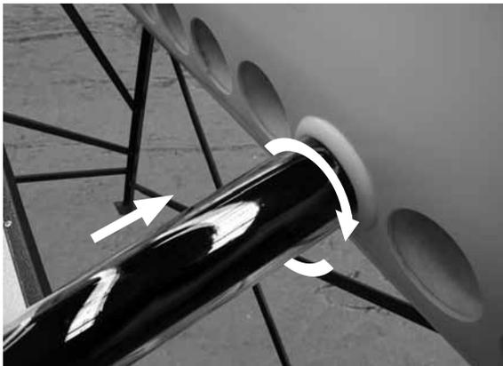
Mojar el tubo de vacío en la parte posterior con solución jabonosa (aproximadamente 10 cm), para insertarlo en el orificio del termotanque, girando lentamente en dirección a las manecillas del reloj y aplicando presión uniforme hasta que el tubo entre, aproximadamente 5 cm.
