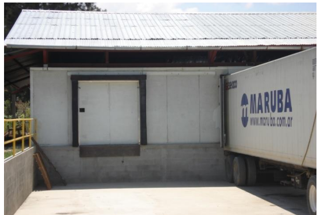
Cuarto frio con anden de carga y contenedor acoplado, Salamá B.V
