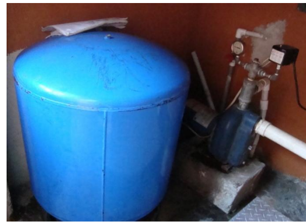
SISTEMAS DE BOMBEO DE AGUA HIDRONEUMATICOS.
