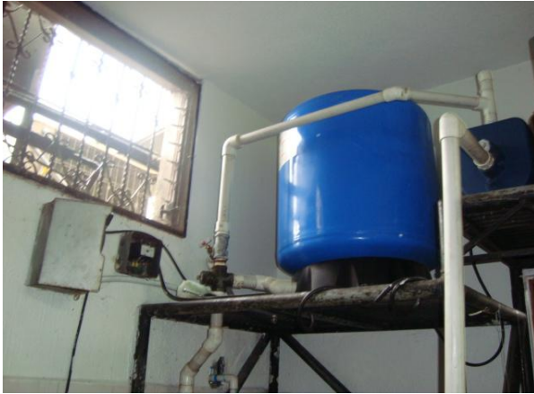
SISTEMAS DE BOMBEO DE AGUA HIDRONEUMATICOS.
