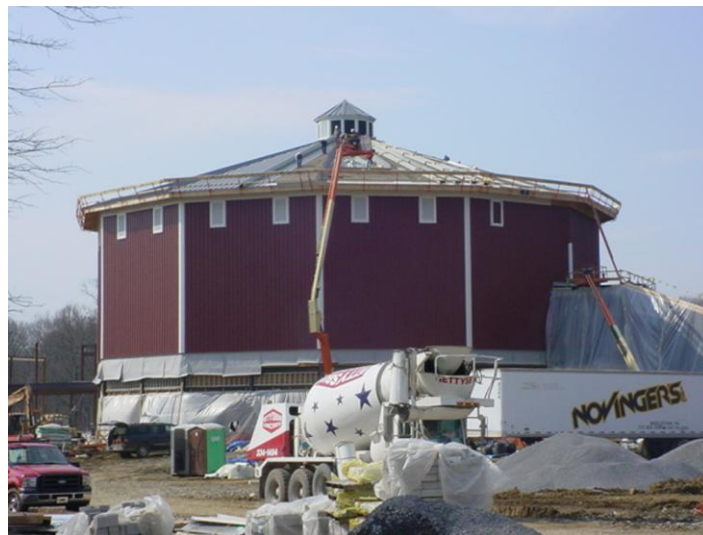
MUNICIPAL AND HISTORIC BUILDING RENOVATION RENOVACIÓN DEL EDIFICIO MUNICIPAL Y CONSTRUCCIÓN HISTÓRICA
