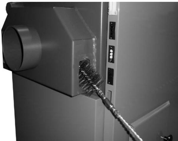
Muestra de la limpieza del canal de humo. Se ejecuta después de limpiar la placa de tubos en la cámara de combustión de la caldera.
