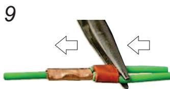
Deslice el Empaque Rojo, hacia arriba; De modo que esté casi en Contacto con el Conector de Cobre. Puede ayudarse de unas pinzas.
