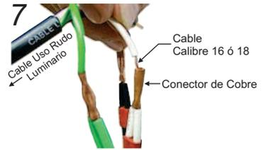
**7** Coloque las terminales (Cable Cal. 16) del Uso Rudo del Luminario en los conectores de cobre. Y Estrangule el extremo superior del conector.
