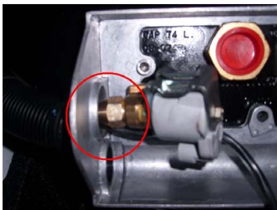
Salida de gas del depósito
