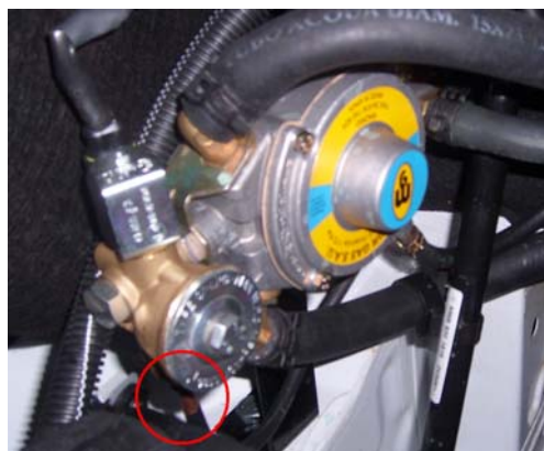
Entrada de gas a la válvula de corte
