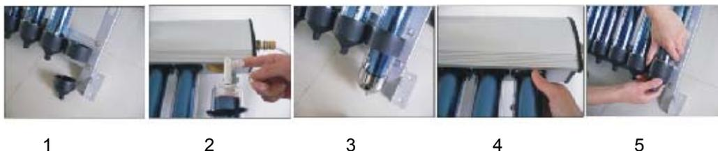
**Paso 1:** Instalar primero el tope de nylon (gorro negro) en la parte inferior del marco y a continuación, fijar con el tornillo la chaqueta exterior de nylon de la PAC.
