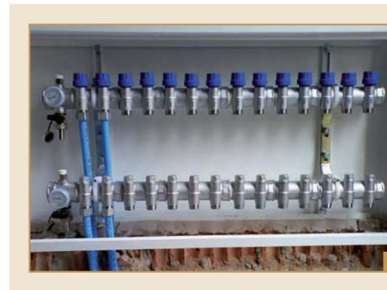
Montaje del adaptador en el colector ALB de suelo radiante. Se recomienda, acorde a la norma UNE EN 1264, realizar una prueba de estanqueidad (ver Anexo 1).
