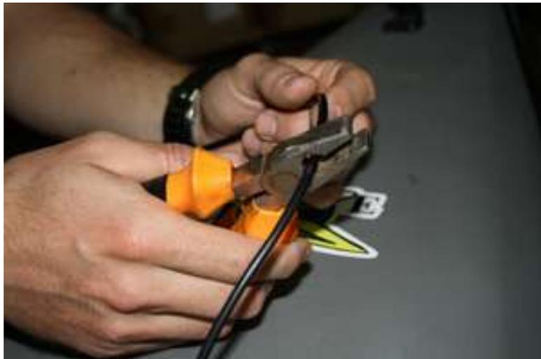
Pelaremos los dos extremos unos 10 centímetros, nos quedaran a la vista dos cables, el rojo (positivo) y el negro (negativo). Volveremos a pelar el positivo unos 3 centímetros, y lo empalmaremos al cable del porta fusible. Una vez empalmados le pondremos un trozo de tubo termoretactil, para una mayor conexión.
