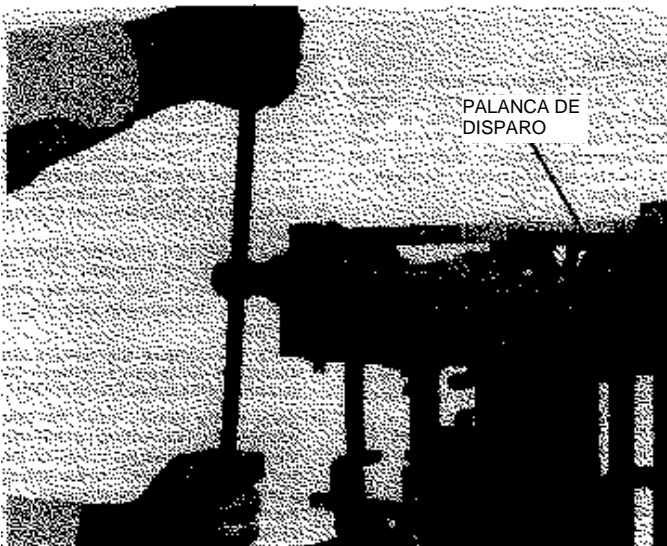
Figura 10. La palanca accionadora suelta el mecanismo cuando el reconector está fuera del aceite.
