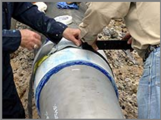
Colocando la cinta de Ajuste al Velcro
