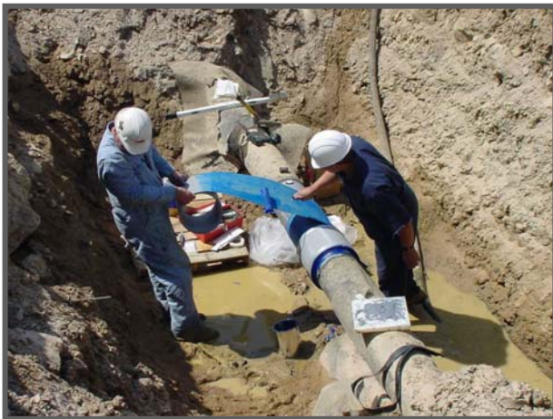
Aplicación del Adhesivo
