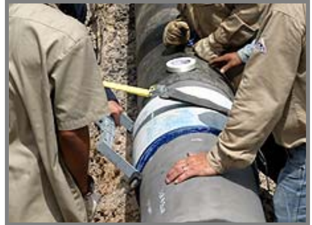
Colocando la Barra de Torque
