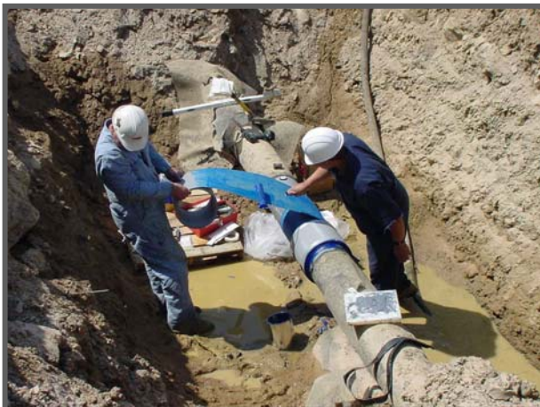
Aplicación del Adhesivo
