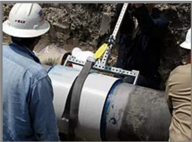
Aplique presión firme a la Barra de Torque
