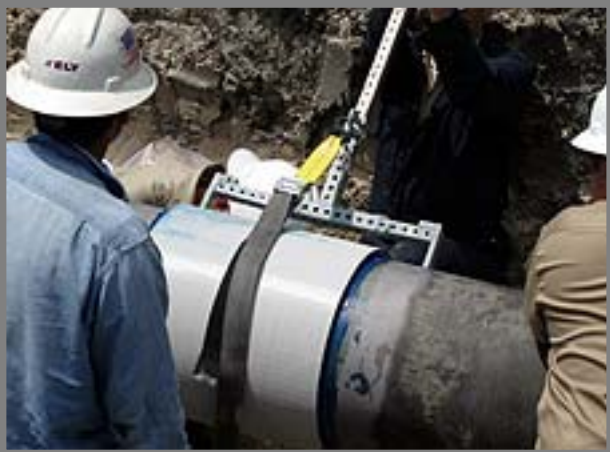
Aplicando presión a la Barra de Torque
