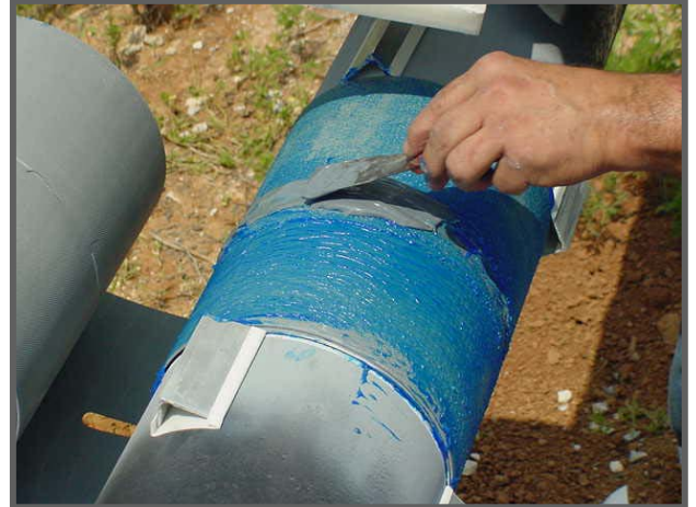
Aplicación de Masilla adicional y relleno del espacio de la costura de soldadura.
