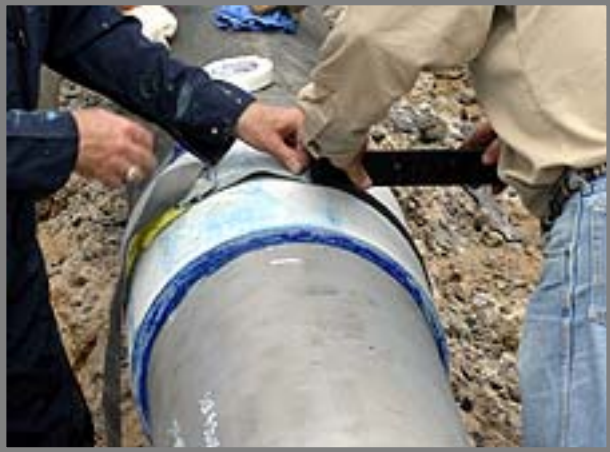
Aplicando presión a la Barra de Torque
