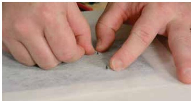
**Figura 11:** Posicione *Reinforcing Fabric* sobre las clavijas localizadoras del cuerpo del drenaje.
