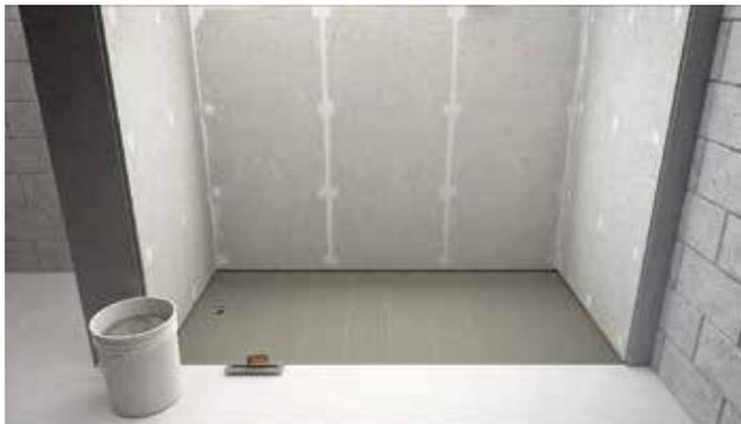
**Figura 6:** MAPEI *Ultraflex RS* usado para instalar la base de pendiente previa y soporte del montaje de drenaje *ShowerPerfect*
