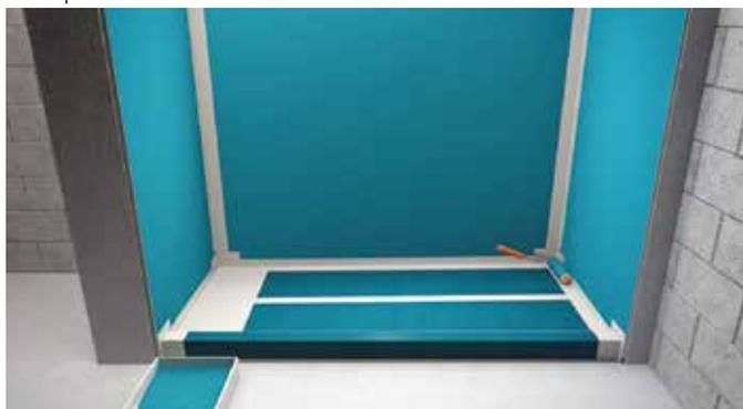
**Figura 12:** Aplicación de *Reinforcing Fabric* y las esquinas interiores *ShowerPerfect LM* con *Mapelastick AquaDefense* de MAPEI
