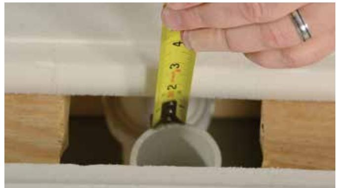
**Figura 5:** Mida desde la ranura rebajada a la parte superior de la tubería de conexión.
