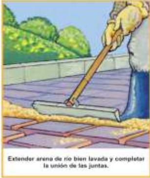
Se extenderá la arena fina y seca sobre el pavimento, procediendo a introducirla en las juntas mediante un barrido manual o mecánico procurando que quede un excedente sobre toda la superficie.
