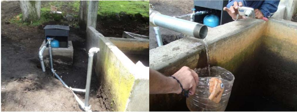
Figura 4. Filtro de carbón activado instalado en Fierro del Toro Huitzilac.
