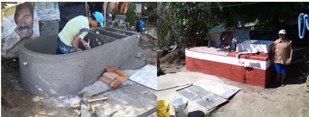
Figura 5. Lavadero ecológico modificado. Proceso de instalación (izquierda), lavadero terminado (derecha).
