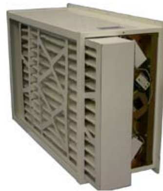
Fig. 2 - Retire el filtro viejo y reemplácelo por un filtro nuevo. Asegúrese de que la flecha del flujo de aire en el filtro esté señalando hacia el interior del módulo.
