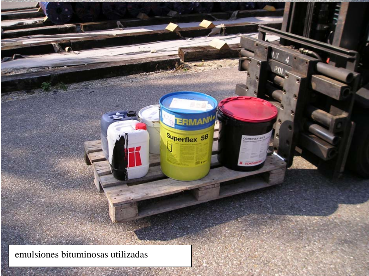
limpieza del asfalto viejo
