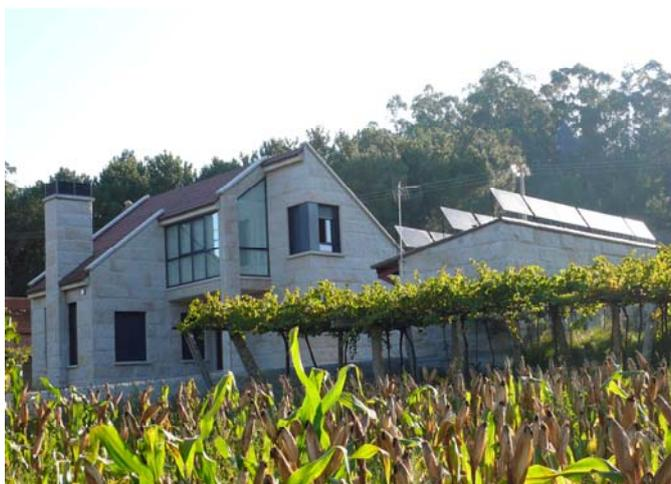
No se permite la colocación de paneles del mismo equipo en distintas aguas de los techados, siempre que la radiación solar no llegue a todos por igual.
