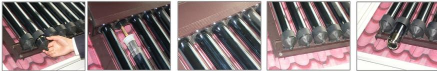
**Paso 1:** Instale el tapón de nylon en la parte de abajo, y saque la cubierta del tapón de nylon.
