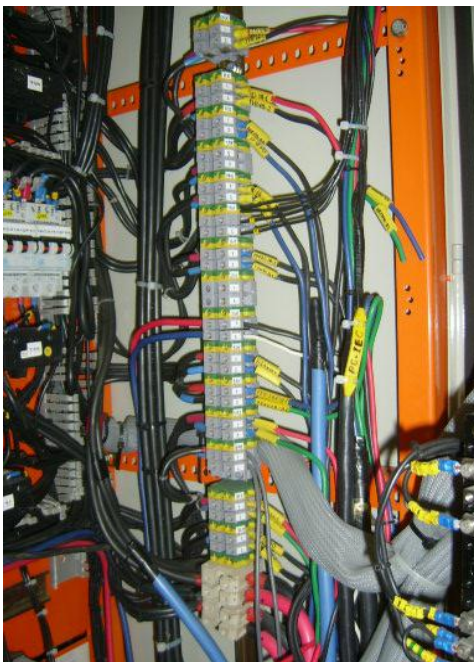
Fotografía 5: Borneras mezcladas de barra 1 y 2
