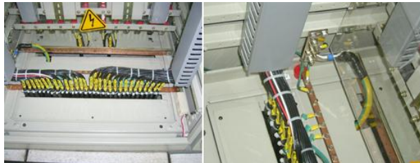
Fotografía 11: Montaje de caja y ductos para alumbrado de emergencia
