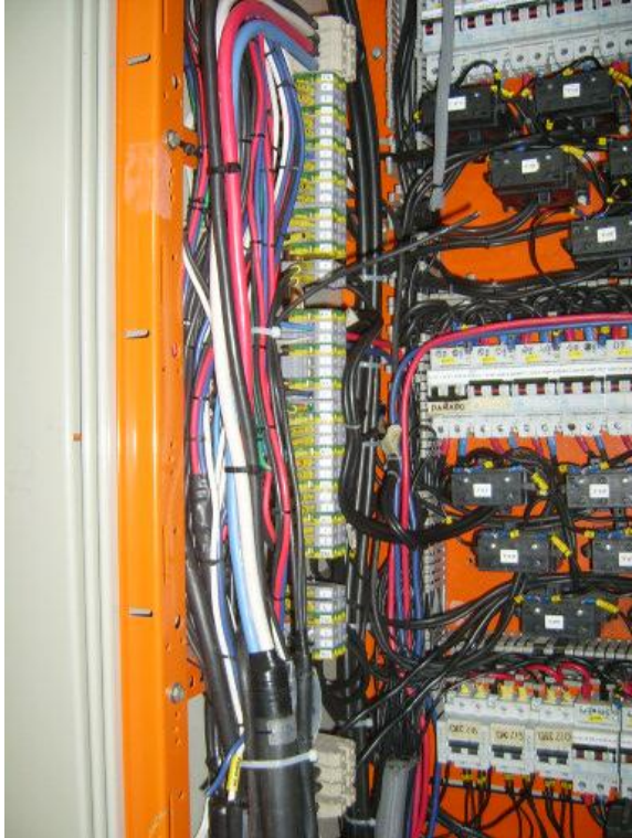
Fotografía 4: Breakers fuera de servicio
