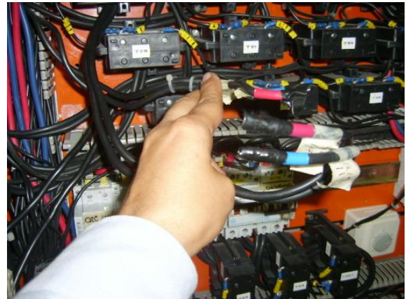
Foto 6: Ejemplo de cableados sueltos
