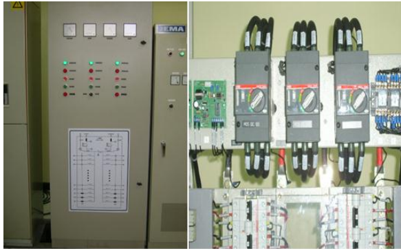
Fotografía 10: Pruebas locales con energización del tablero para amarillado del cableado
