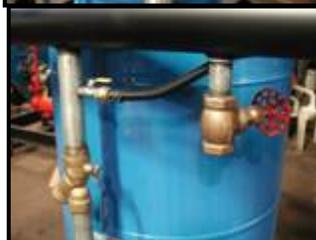
En equipos en los que se especificó que por su colocación quedarán ahogados (succión positiva) se entregan con válvulas de retención en lugar de las “Y” griegas. Estos equipos no requieren cargarse al estar auto cebados por la fuerza de la gravedad. Como no llevan válvulas de pie en la succión es necesario colocar válvulas de retención que evitan la descompresión del sistema al apagarse el equipo, así como la recirculación entre motobombas.
