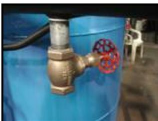
Esta válvula se conecta con la cisterna y es muy práctica para probar el funcionamiento del equipo, así como calibrar los diferentes ajustes en caso necesario
