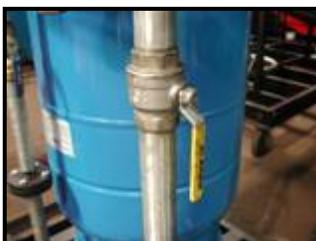
Cada motobomba tiene juego de bridas que permite su desconexión, conexión. “Y” griega para el cebado inicial y válvula seccionadora para mantenimiento.
