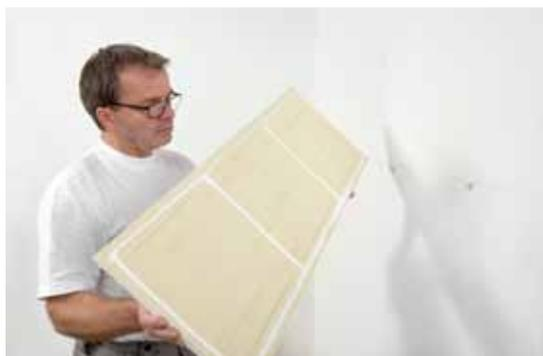
Posicionar los paneles y encajarlos con un movimiento deslizante.
