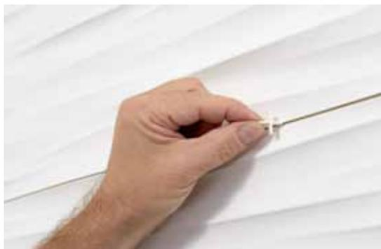
Las zonas de junta de tope no deben pegarse o fijarse. Hay que precisar que las zonas de unión permanecen visibles a simple vista tras el montaje. Esto no representa ningún motivo de reclamación.
