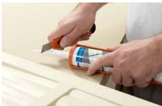
Colocar el cartucho adhesivo, cortar el inyector del cartucho (diámetro 5-8mm).
