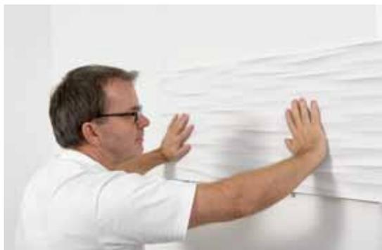
Se recomienda colocar separadores en los modelos LIQUID y WAVE para mantener una distancia simétrica entre paneles. Para los otros modelos no son necesarios los separadores.
