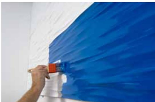
En caso de que la pintura de acabado no haya sido aplicada antes de la colocación de los paneles, dejar completar el tiempo de secado (aprox. 4 horas) antes de aplicar la capa de acabado.
