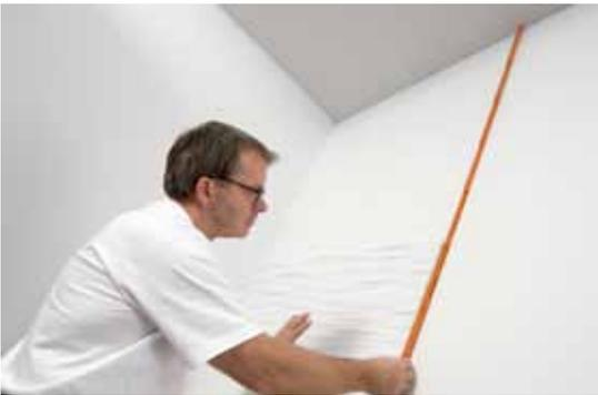
Medir la superficie de la pared y determinar el lugar donde irá colocado cada panel utilizando un nivel.
