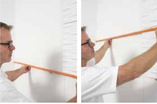
Medir el tamaño de los paneles que han de colocarse en las zonas de unión con las paredes laterales y el techo y trasladar la medida al dorso de los paneles.
