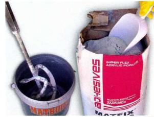
Prepare el mortero o cemento-cola respetando la cantidad adecuada de agua para conseguir una correcta adherencia y consistencia
