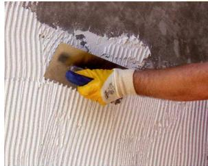
Se recomienda aplicar el mortero o la cola sobre la superficie a cubrir por tramos para evitar que se seque el mortero durante la colocación de la piedra.
