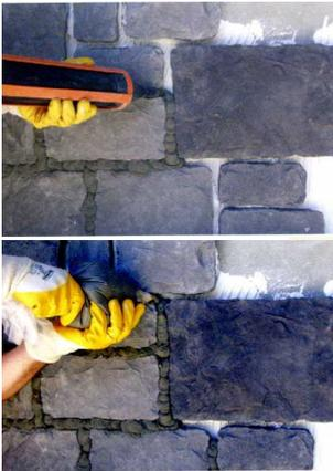
Para la preparación de las juntas se puede utilizar una manga o una pistola específica. En ambos casos corte el extremo según el ancho de junta deseado.
