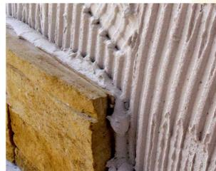
Presione fuertemente la piedra sobre la superficie para garantizar una buena adherencia del mortero. La cantidad de mortero/cola aplicada debe ser la suficiente para que se desborde cuando se aplique presión.
