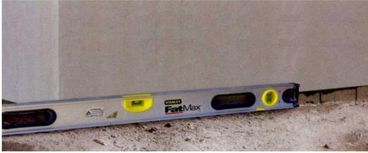
Para una buena adherencia del mortero la superficie a cubrir debe estar libre de suciedad y polvo. Nivele la base donde se piensa colocar la primera hilada.
