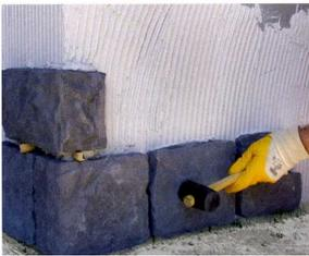
Siempre que la instalación incluya piezas de esquina, se recomienda empezar la colocación por las esquinas y continuar con las piezas planas siguiendo la hilada.
