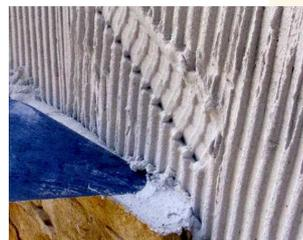
Rellene la ranura perimetral con mortero/cola usando una llana. Retire masa sobrante para evitar manchas en la superficie de la piedra.
