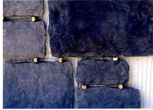
Si la piedra se coloca con junta se pueden utilizar distanciadores (por ejemplo tacos de madera) para fijar la piedra en su posición correcta.
