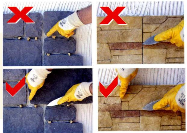
Durante la colocación de las piezas debemos evitar la formación de juntas verticales en hiladas seguidas.
