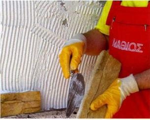
Para una mejor unión entre piezas, limpie los cantos de las piedras de excesos de hormigón mediante una llana o herramienta adecuada. Si el dorso de la piedra está seco humedézcalo con agua para evitar que absorba el agua del mortero.
