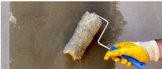
Si vamos a trabajar sobre una superficie absorbente, como planchas de cartón-yeso o madera, debemos aplicar una imprimación para reducir la absorción.
