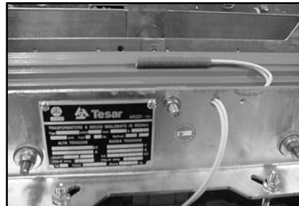
Fig. 4 Doble Pt100 sobre el núcleo
